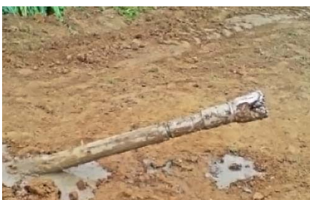
Fot. 2. Silnik w głębinie po wykonaniu otworu pilotażowego
