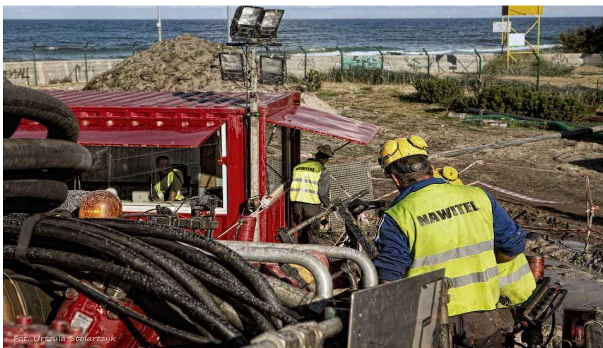
Przewiert HDD pod dnem Morza Bałtyckiego. Fot. Nawitel
