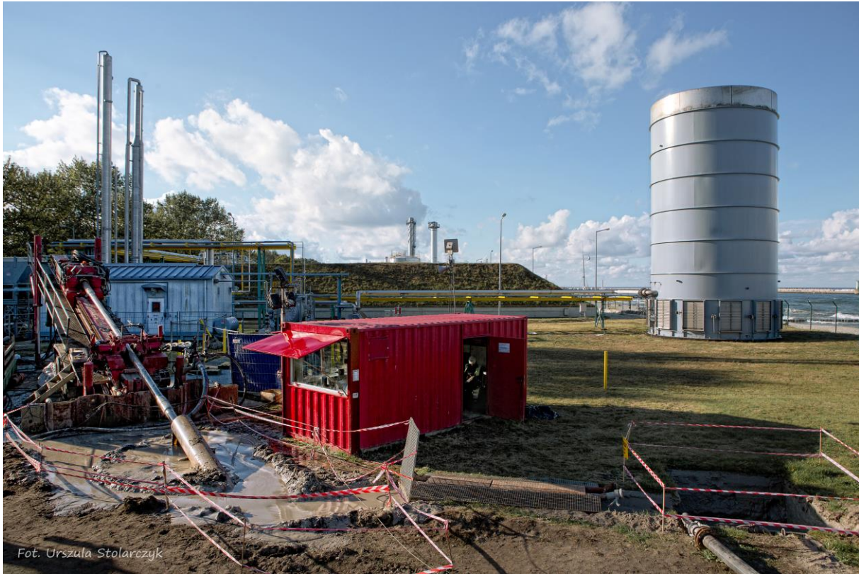
Przewiert HDD pod dnem Morza Bałtyckiego. Fot. Nawitel
